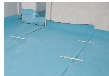
(3) \pm 10 cm tegen de muren naar boven komen voor de realisatie van de chape
